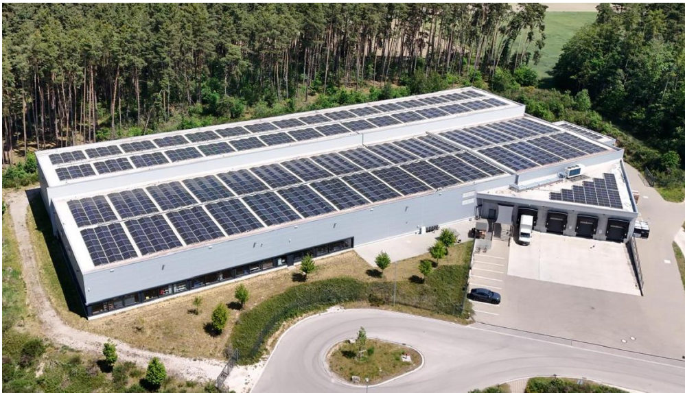
Uno dei quattro capannoni produttivi nello stabilimento di Saal Digital a Röttenbach (Germania) © Saal Digital
